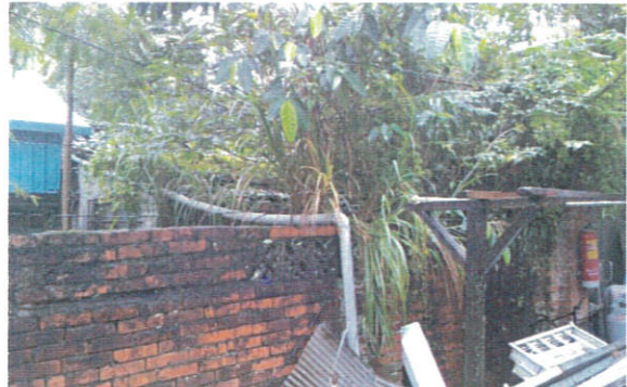
4. 國校路 65 巷 19 號-前院及屋頂(右側雜草叢生處)
